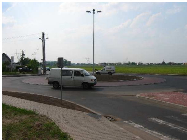
Rondo w Wieruchowie Największa inwestycja powiatowa w 2004r. - koszt budowy wyniósł 1,4 mln.
